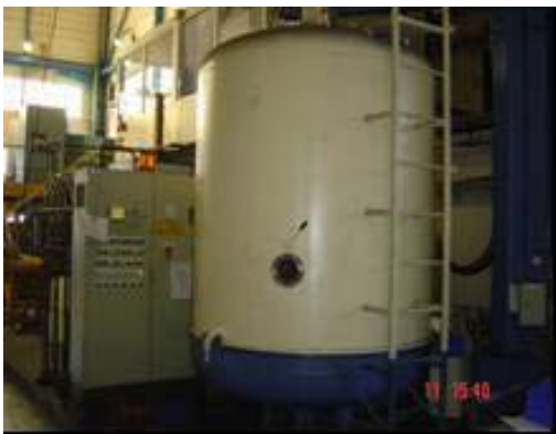
Dispositif de nitruration ionique
